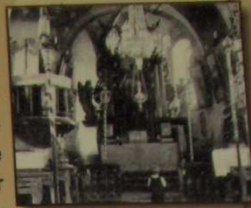
Der Innenraum der St.-Georg-Kirche Interiér kostela sv. Jiří
